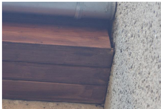
Neuer Dachkasten mit Einflugschlitz
