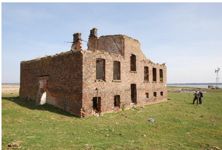
Zukünftiges Ganzjahresquartier für Fledermäuse auf dem Riether Werder
