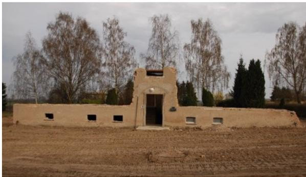
*Zustand des Kellers mit ehemaligem Treppenabgang mit neuer Betondecke und verschlossenen Fenstern im Oktober 2018 (Fotos: A. Petzold).*
